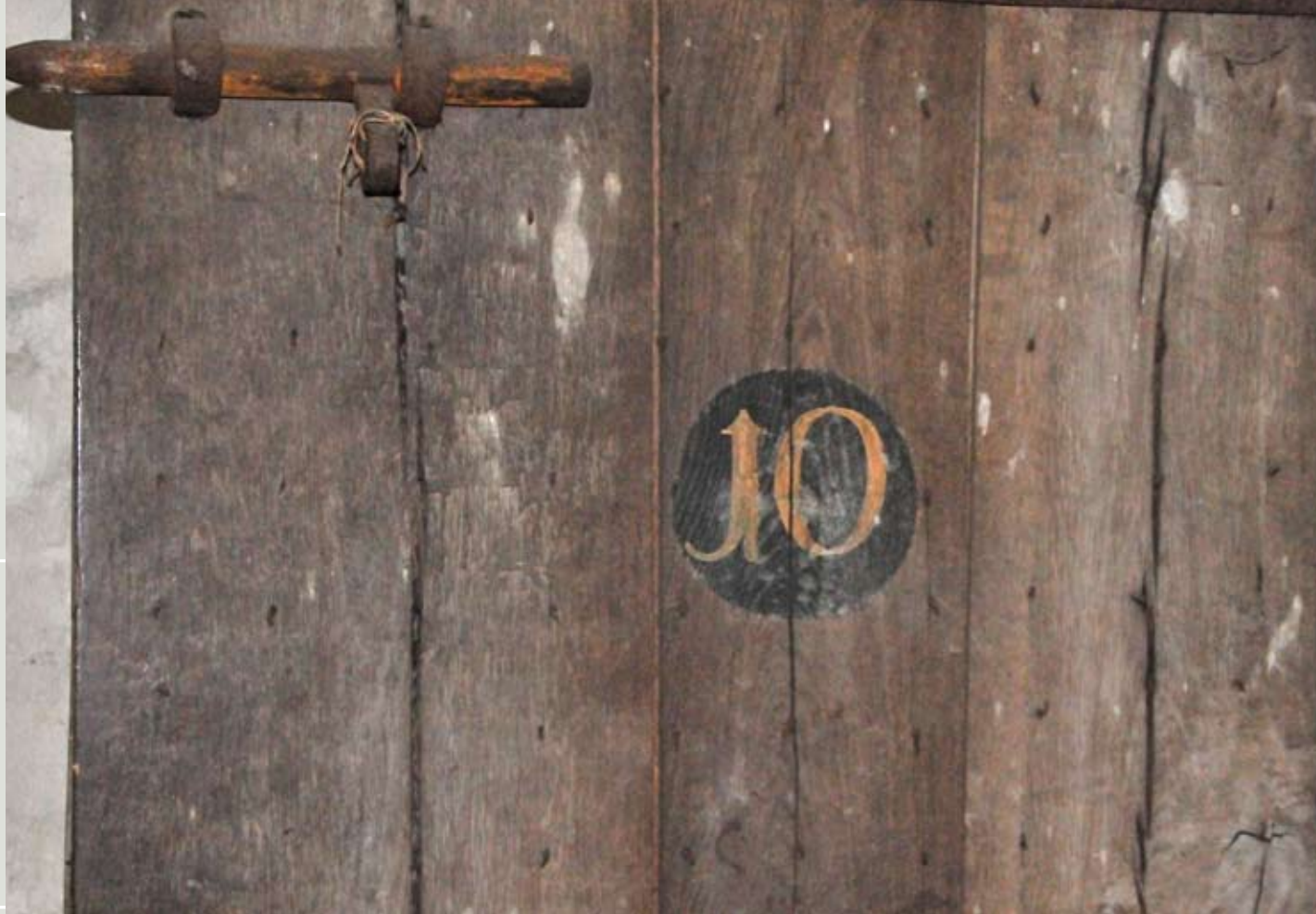
Buitenkant celdeur cel 6 met oude nummering
