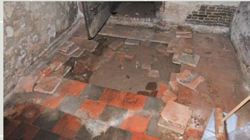
Cel 4 gat in de plavuizenvloer met eronder een gat in de kloostermopvloer
