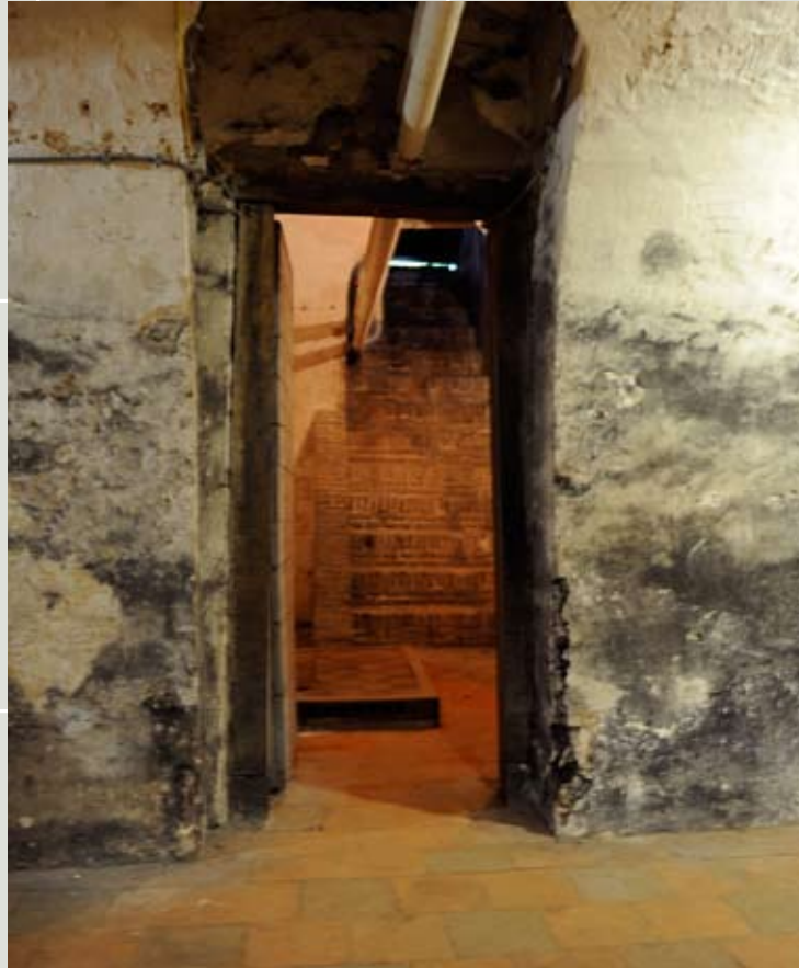
Ruimte 8, verwarmingshok met trap naar binnenplaats
